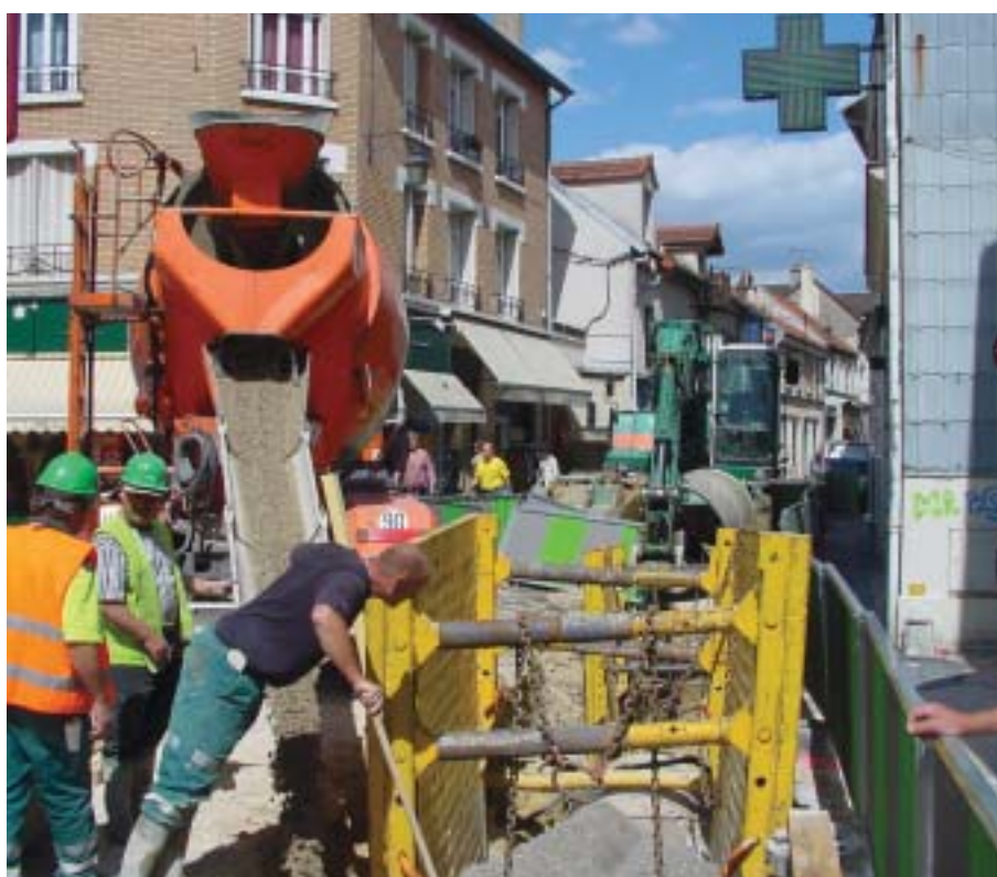
En centre-ville, l'année 2004 aura été marquée par l'imposant chantier de réfection du réseau d'assainissement.
