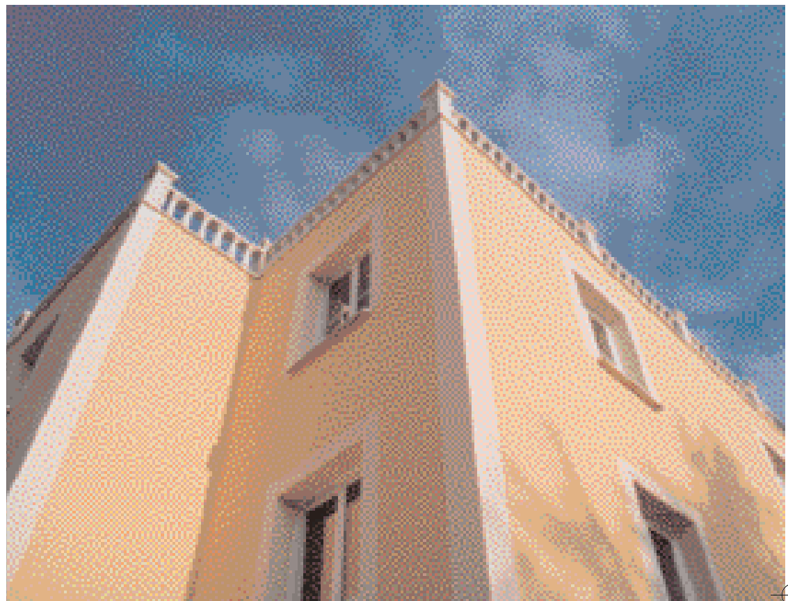
Depuis quelques semaines, des couleurs chaudes sont apparues sur le bâtiment situé à l'angle des rues Camille-Pelletan et Edouard-Branly.
