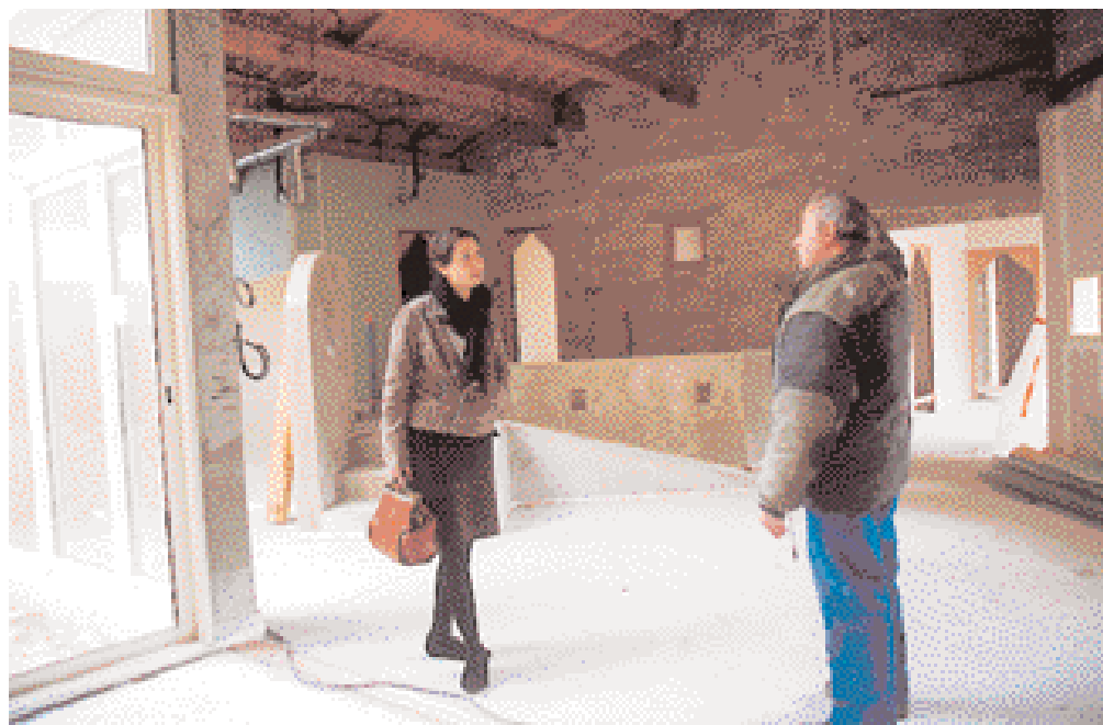
Sylvie Aid visite le chantier de la nouvelle mini-crèche Carnot.
