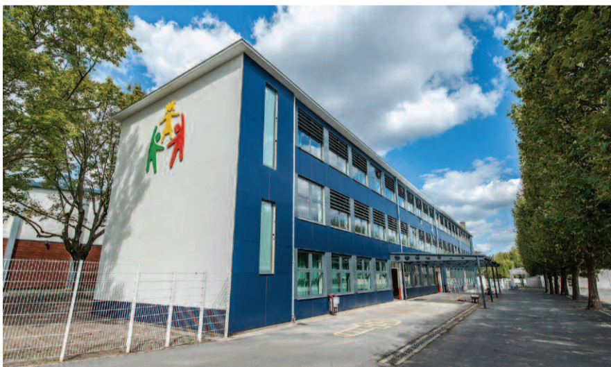
L'école du Réveil-Matin a fait l'objet d'une rénovation totale des façades et des toitures.
