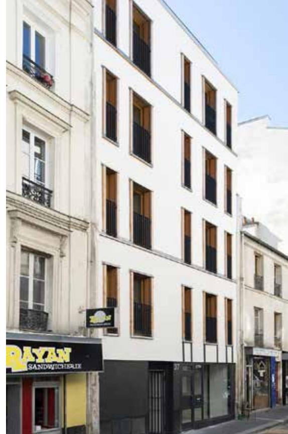
↑ L'ossature primaire du bâtiment est en métal et l'ossature secondaire en bois avec remplissage en béton de chanvre.
